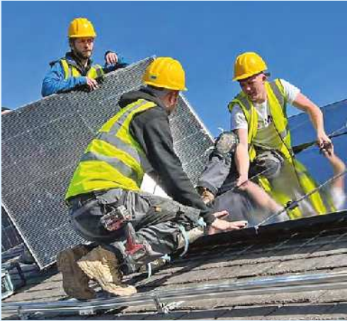
Gweithwyr Menai Heating wrthi'n ddyfal yn gosod y paneli solar ar do'r Neuadd
